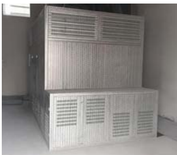
图 8-9 主整流变压器
