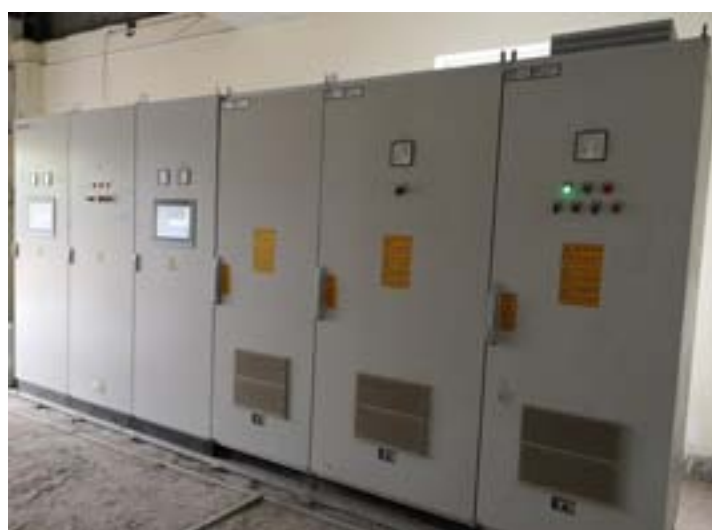
图 8-4 PLC 及接口控制+闸控+重力滑行控制
