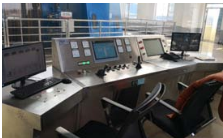
图 1-2 CZT404 桌型操作台（双液晶 OP+上位监控）
