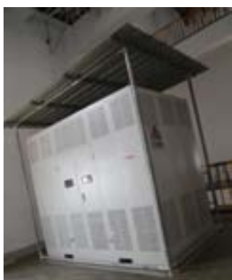
图 6-4 1) 整流变压器
