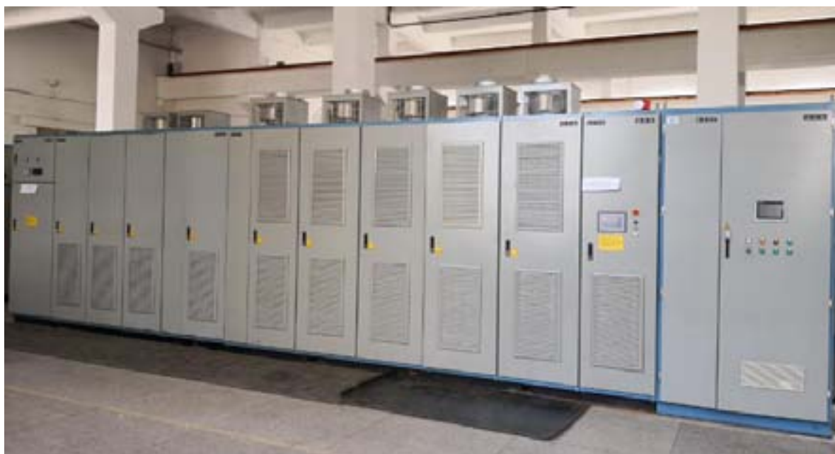
图 4-1 6.0kV 低频直驱高压变频器（高原水冷型）
