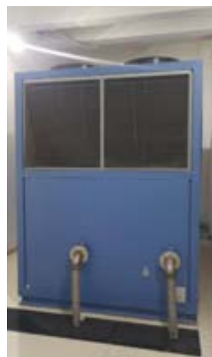
图 2-6 变频器外水冷机组
