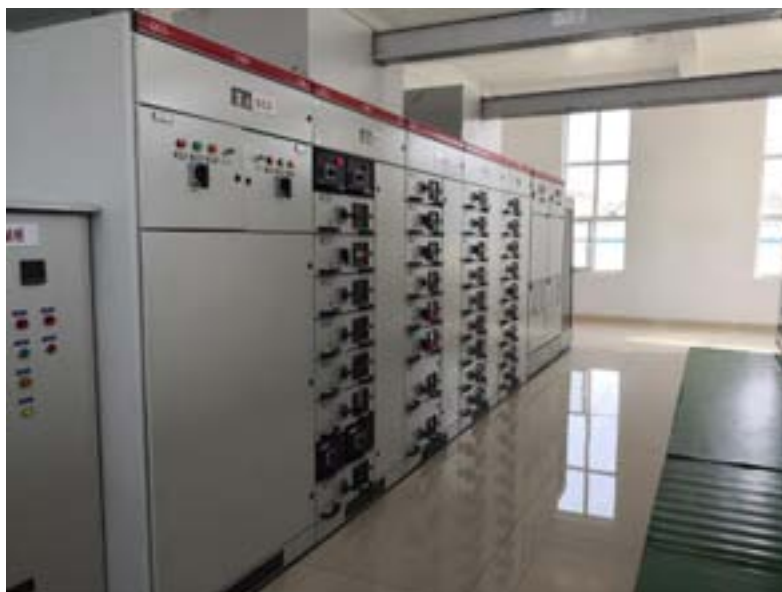
图 2-10 MNS 型低压开关柜
