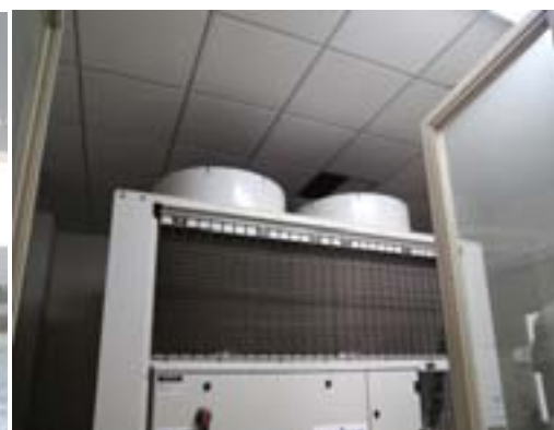
3) 变频器外水冷机组
