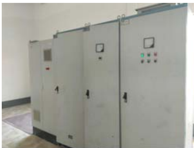
图 7-3 PLC 及接口控制+恒减速闸控
