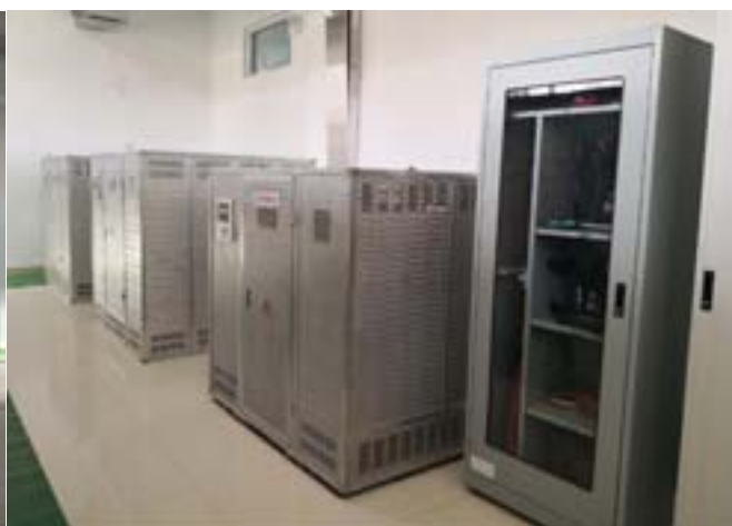
图 2-8 励磁+辅助变压器
