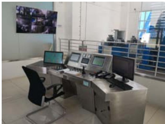
图 2-2 CZT404 桌型操作台（双液晶 OP+上位监控）
