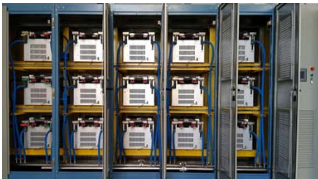
图 2-4 6.0kV 低频直驱中压变频器主回路（单相 5 级级联）
