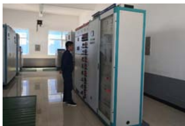
图 1-7 MNS 型低压开关柜
