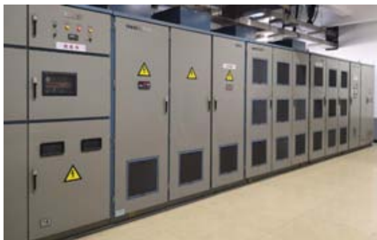
图 1-3 6kV 低频直驱同步机高压变频器（水冷型）
