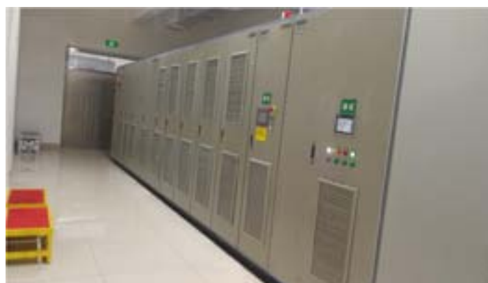
图 2-3 6kV 低频直驱同步机高压变频器（水冷型）
